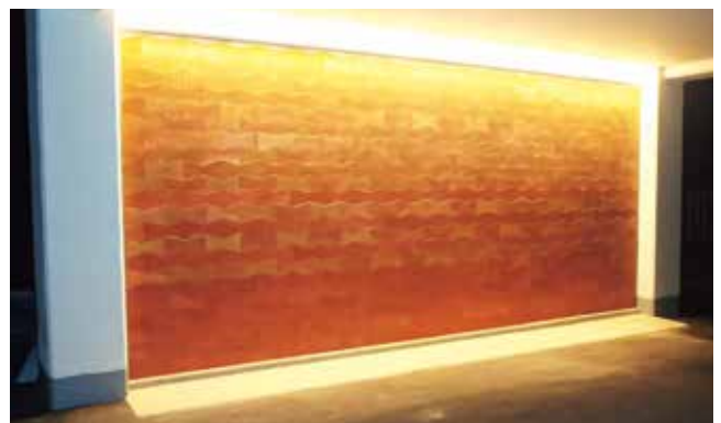
写真1 カラーコンクリートによる補強事例（新倉竹友寮）
