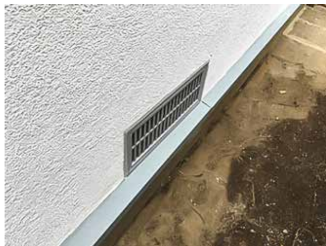
床下換気施工例：形状記憶合金 オート床下換気
