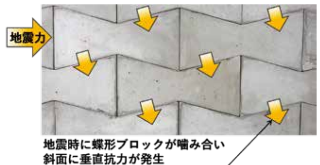
図2 蝶形ブロックによる地震時の応力伝達
