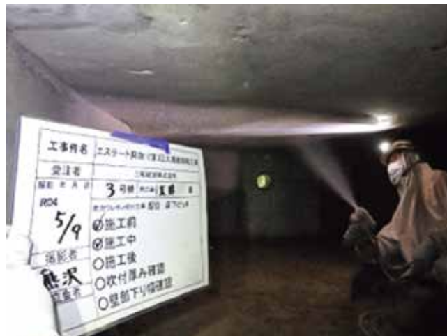
床下施工例：ウレタン30mm吹付
