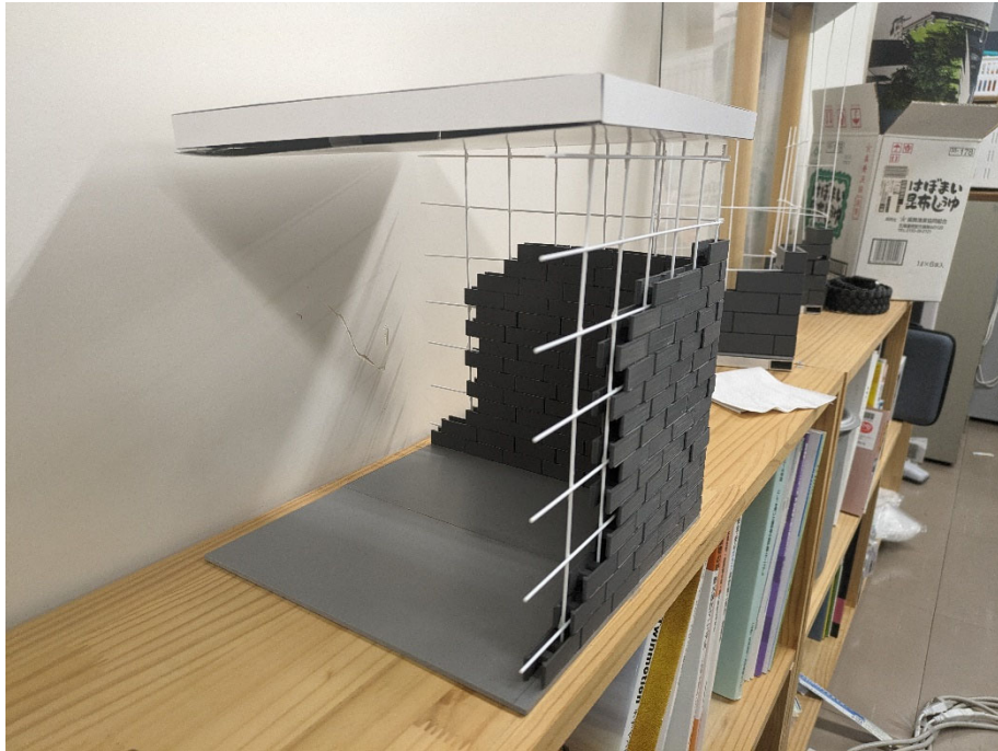
図 6.4.6-4 「臥梁・床スラブ一体型」水平後面の施工 (2/2)
