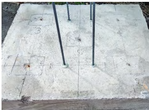
(a) 補強筋のあと施工 (1/2)
