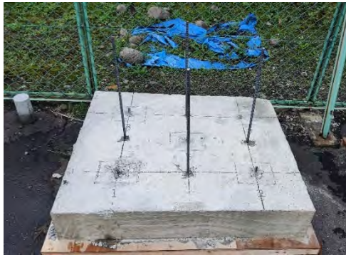
(a) 補強筋のあと施工
