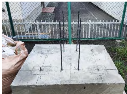
(b) 補強筋のあと施工 (2/2)
