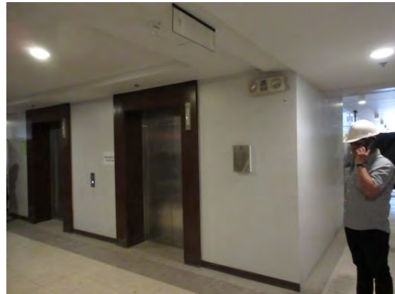
エレベーター周り。耐震壁となっており、クラック無し
