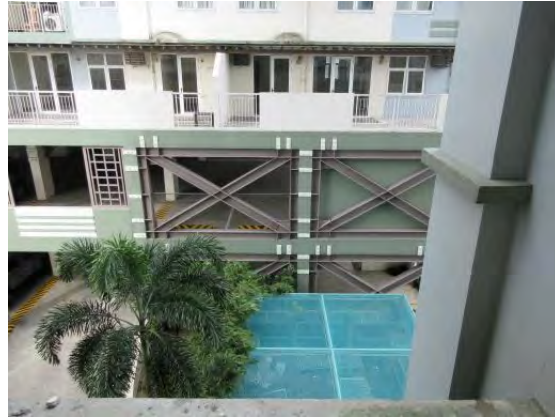
工事中に 2019 年地震を経験。その際に追加された鉄骨ブレース
