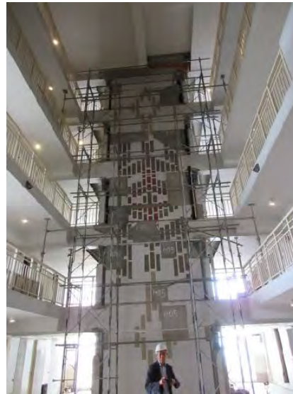
吹き抜けに設置された補修工事用足場
