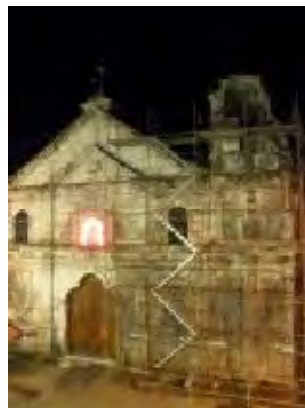
被災直後のサント・ニーニョ教会 補修工事用の足が組まれている
