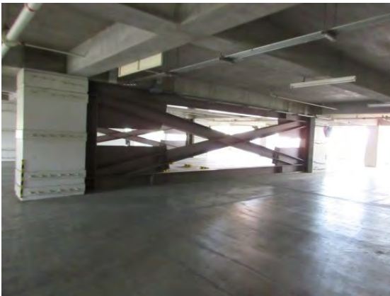
2019 年地震後に追加された鉄骨ブレース
