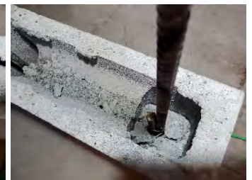
写真9 No.16のモルタル充填状況
