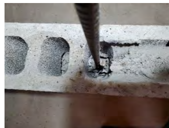
写真8 No.15のモルタル充填状況
