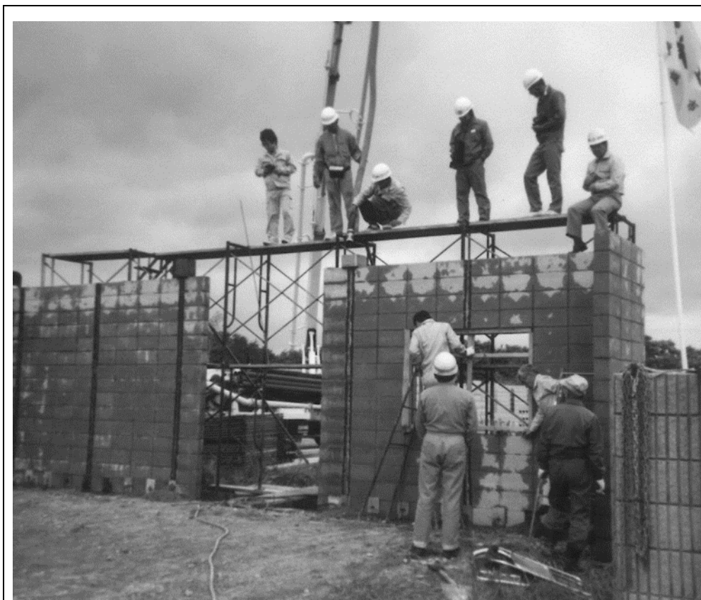
充填モルタルの階高充填状況
