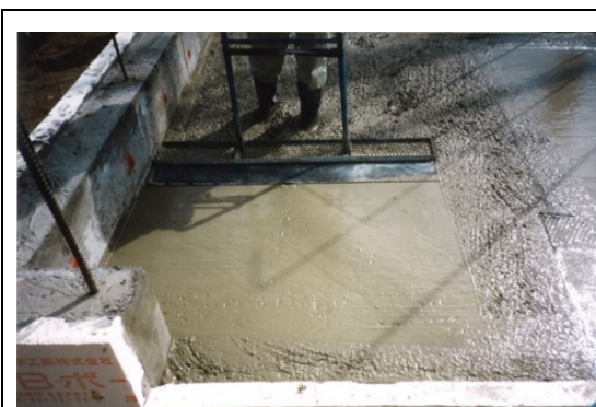
土間コンクリート打設後の、表面の仕上げ作業中
