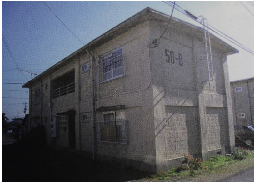
1950年 群馬県営住宅 (石炭ガラを原料のブロックを帳壁に)
