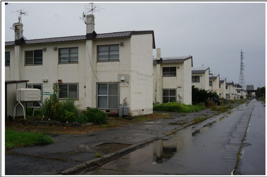
1970年代 市営住宅(恵庭市)(軽量 CHB によるブロック建築)
