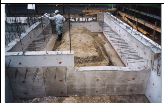
基礎のコンクリート打設後、型枠解体が完了。土間コンクリートのアンカー鉄筋、壁縦筋の状態を確認し、基礎天端の高さと水平状態を、モルタルにより補正した状態である
