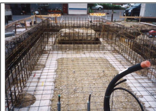
ベースと基礎の配筋工事が完了
