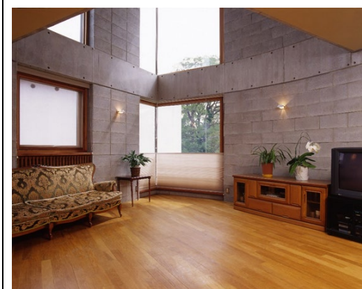
CHB 壁面は粗面目地仕上げ
