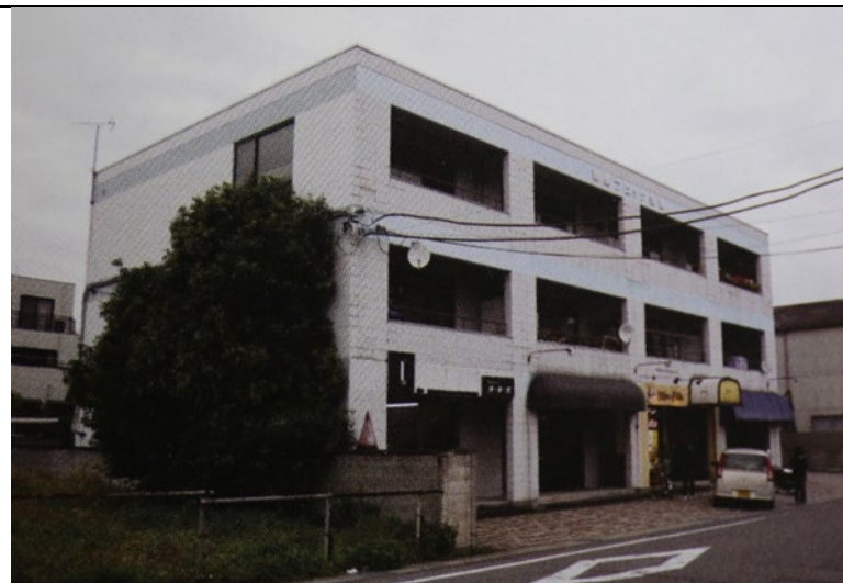
1987年竣工 群馬ブロック会館～補強 CHB 造 3階建て
