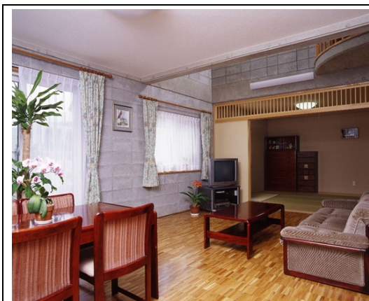
CHB 壁面は粗面目地仕上げ
