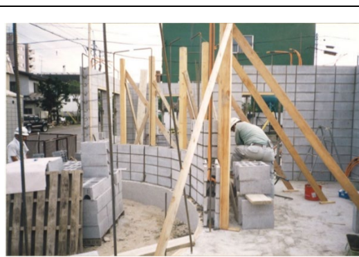
墨出しと縦やり方を先行し、ブロック積作業中。壁の一部がカーブしているため、縦やり方を細かく立てている。縦筋が、梁位置まで立上っている
