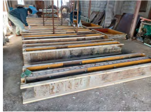
(b) 型枠の搬入
