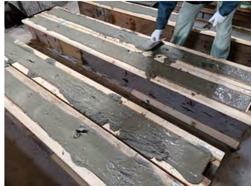
(v) 天端の均し
