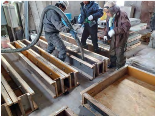
(u) 生コンの打設
