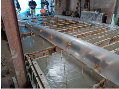
(m) アンカー筋の縦穴位置
