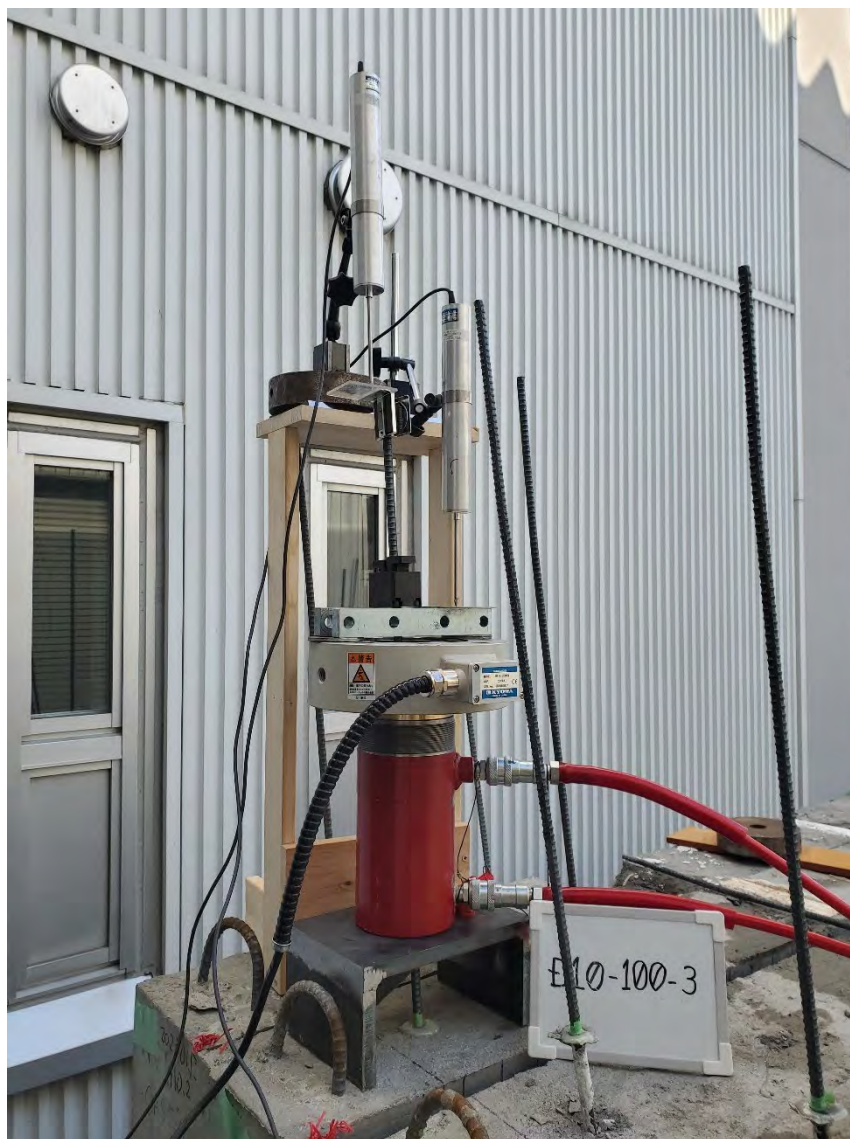
写真 5.7(4)-3 鉄筋の引抜試験の実施状況
