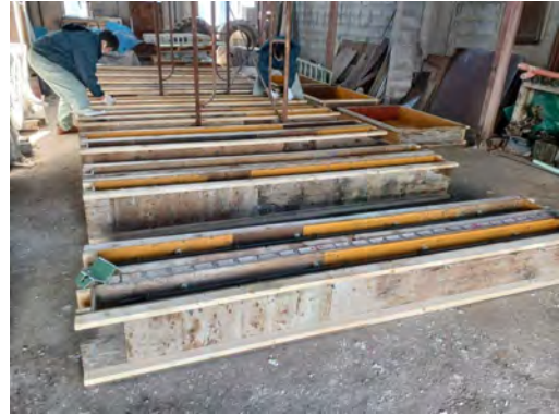
(h) 型枠の搬入
