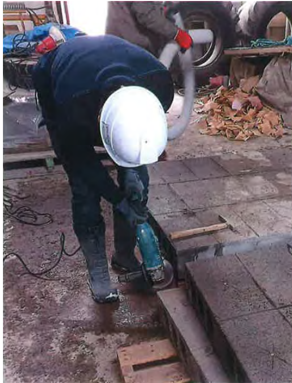
写真 5.6(2)-4 実験のための切断面の成形
