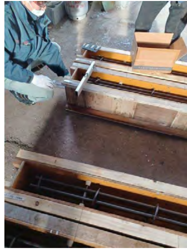
(n) 型枠のレベル出し
