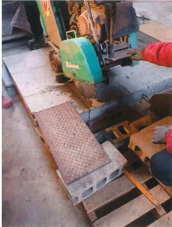
写真 5.6(2)-2 実験部位の切断状況
