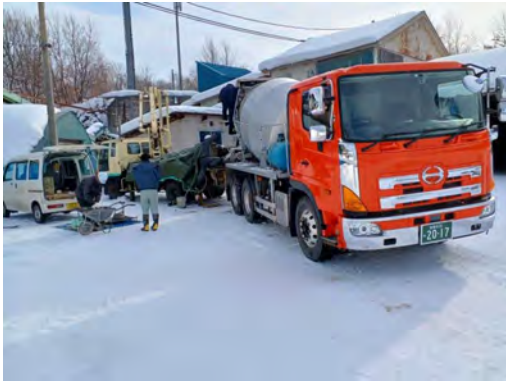
(s) 生コン圧送
