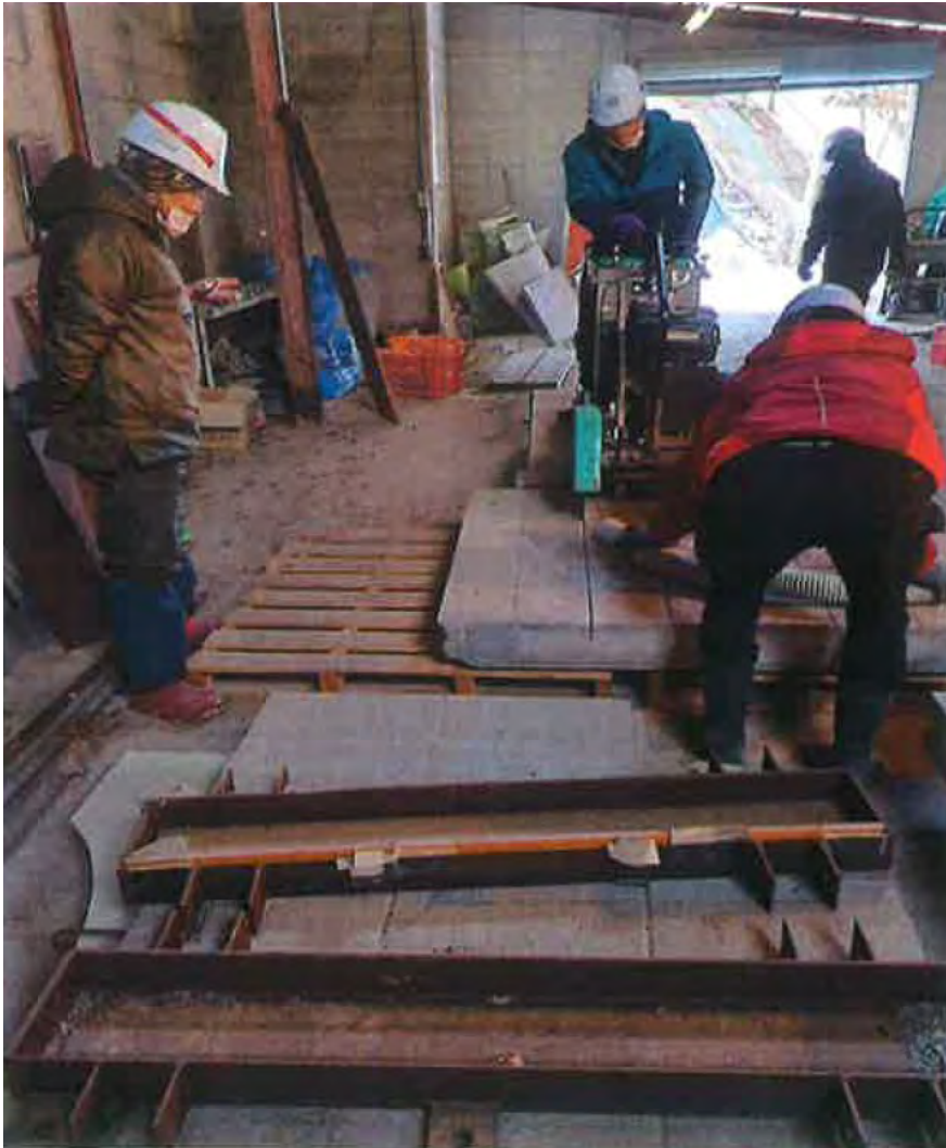
写真 5.6(2)-1 実験部位の切り出し作業
