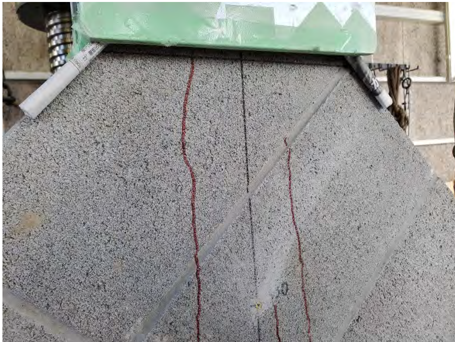
写真 5.6(2)-2 試験体 B の破壊状況(2):表面の上端加圧部
