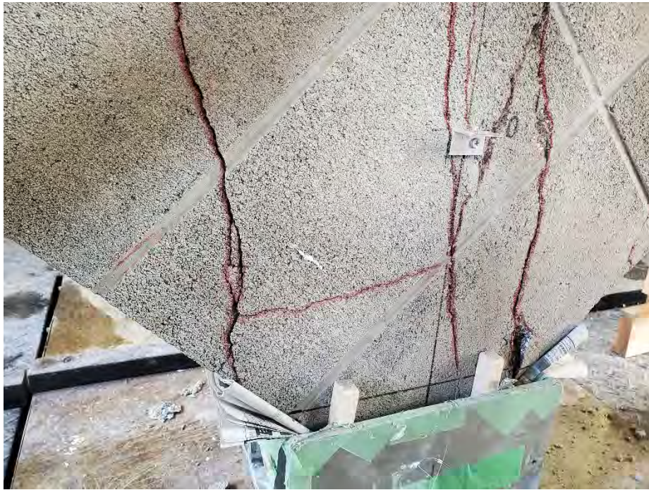
写真 5.6(2)-2 試験体 B の破壊状況(3):表面の下端加圧部
