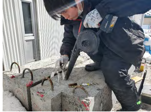
(b) 先穴の清掃作業
