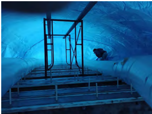
(o) 採暖シートによる養生(1)
