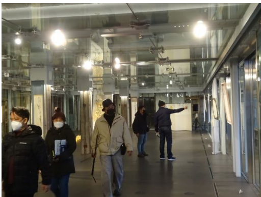
西置繭所1階の補強。鉄骨フレームを利用して、展示、イベント等に活用できるガラスの部屋を設置
