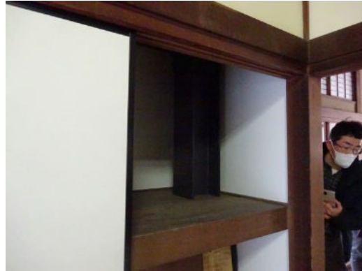
同左 建物内の鉄骨柱
