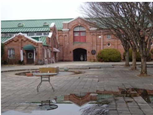
発酵棟(現在、記念館)の全面外観
