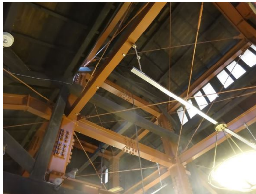
同左 鉄骨の柱、梁、小屋組み
