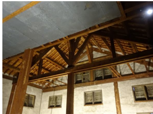
西置繭所2階の補強。カーボンファイバーロッドのブレースなどを活用
