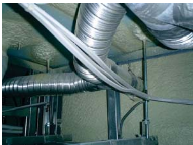
アルミフレキシブルダクト (抵抗大)の例
