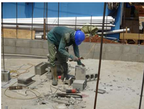
写真 7-11 日系デベロッパーの現場のブロック積 み状況
