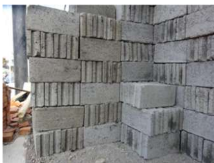
写真 7-4 建材店で見かけたコンクリートブロック
