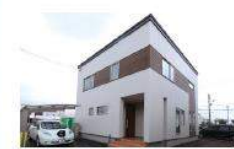
電池蓄積のモデルハウス
