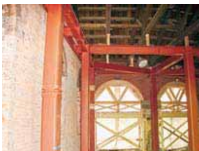
施工中の補強鉄骨、柱継手がイーカプラ
