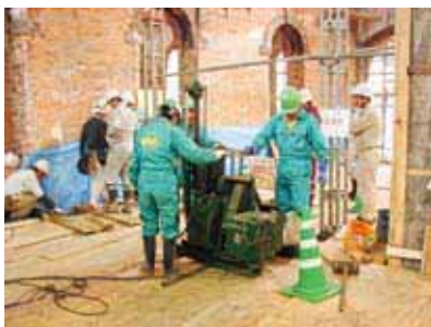
補強鉄骨柱の基礎となる地盤改良体の施工
