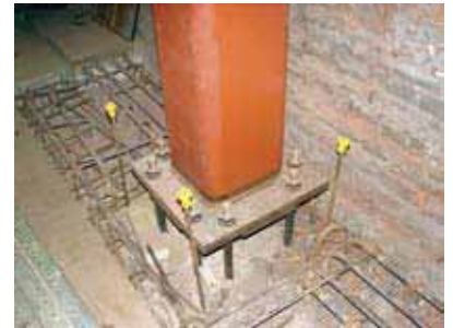
補強鉄骨柱の柱脚
