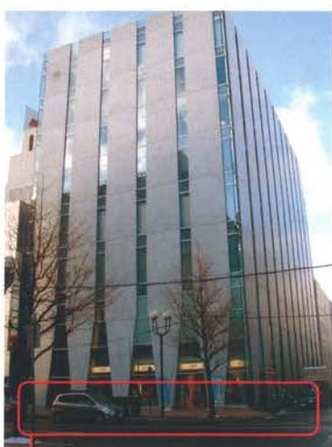
▼外壁脚部を半剛接合としてオイルダンパーを設置
