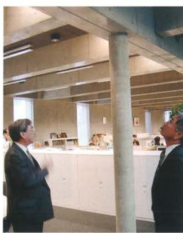
▲電信柱より細い柱で鉛直荷重を支持
