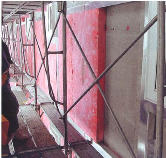
**『省エネ』** 外断熱工法の次世代型省エネルギー基準ではI地域の壁においてはCランクの断熱材が75mm必要ですが、高性能品であるサンボード外断を75mm施工すると約90mmに匹敵する性能が得られます。
