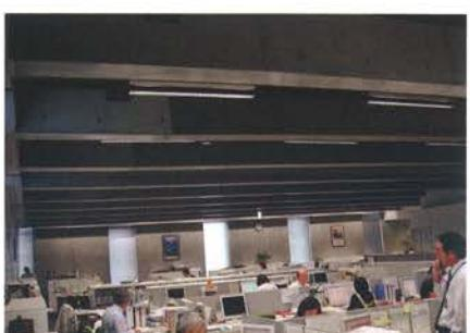
▲プレキャスト+プレストレス梁による大スパン架構。天井仕上げを施さず梁断面を統一することにより、ローコスト化と開放的空間を実現
