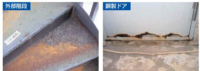
写真6：外部鉄部の錆び
