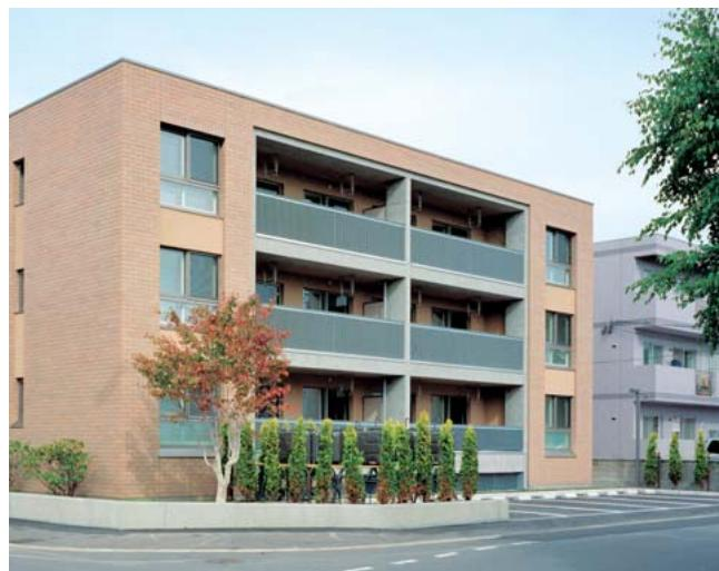
その中でもっとも適した材料が、剥落がなく、雪かきなどでへこまない、耐震性のある北海道農材工業の外断熱通気層工法のレンガシステムでした。断熱材は外断熱の水蒸気を逃がし、断熱性能の低下のない、撥水性のあるグラスウールを使用しました。
