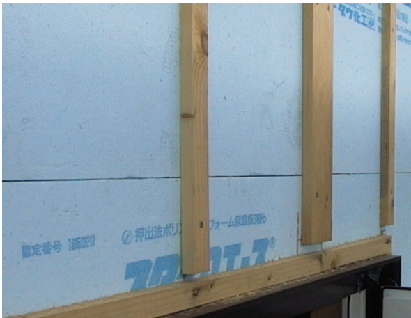
写真 1.1 標準的な外張断熱工法
