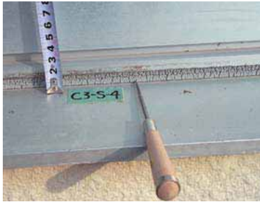
写真3：シーリング材の調査
