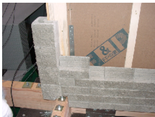
解説写真 2.2 支持部材へ固定するユニットと固定しないユニットのある重量系外装材の一例
