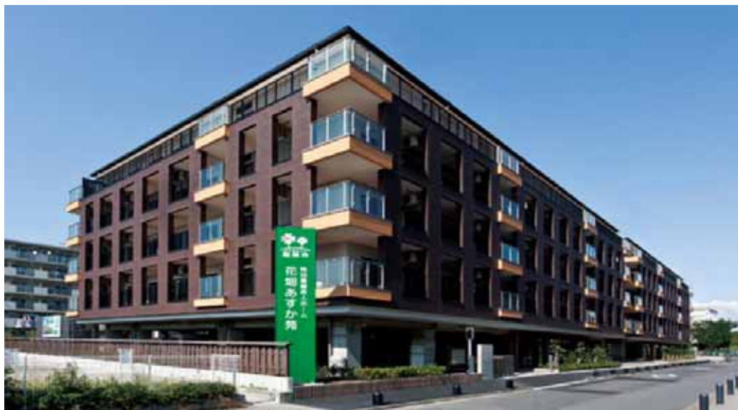
特別養護老人ホーム(東京都足立区、準防火地域) 構造：1階RC造、2～5階(居住ユニット160床)枠組壁 （居住階を木造とした、快適な生活環境の提供） 延べ床面積：9,773.24m 2 国土交通省木造建築技術先導事業(H26)
