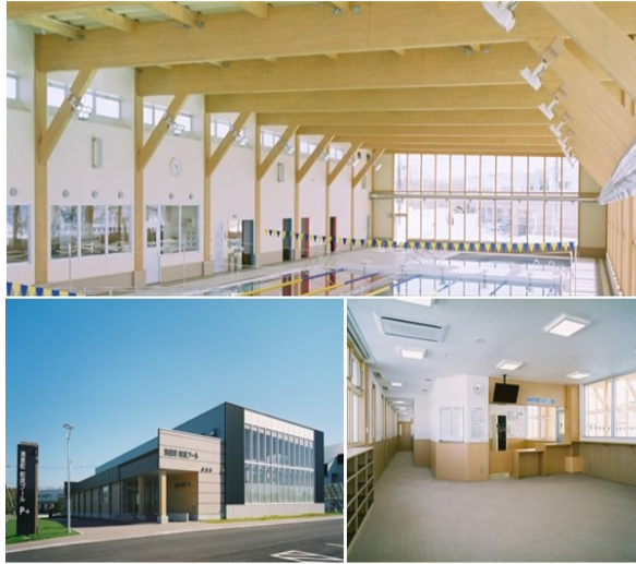
清里町町民プール（清里町、木造平屋建て、998m 2 ） （500m 2 超、1000m 2 以下 ⇒ 構造計算書の添付が必要）
