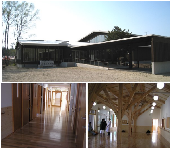
川湯の森病院（弟子屈町、木造一部RC造2階建て、2,940m 2 ） （1000m 2 超 ⇒ 階数、用途に応じて防耐火規定等に関する詳細対応が必要）
