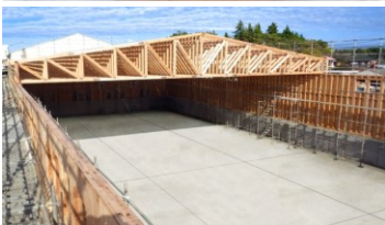
工場施設（栃木、914m 2 、21mスパン、構造材はスギ材・カラマツ合板で国産100%、4mスタッド+基礎高2m）
