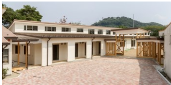
工場施設（栃木、914m 2 、21mスパン、構造材はスギ材・カラマツ合板で国産100%、4mスタッド+基礎高2m）
