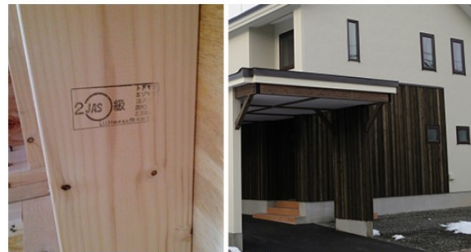
左/含水率が低く、寸法精度の高い道産とどまつを使用し、可能な限り後々の狂いを少なくしている 右/外壁（1階部分）に下川町道産カラマツを使用
