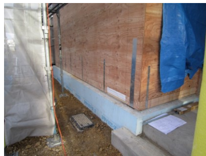
左/含水率が低く、寸法精度の高い道産とどまつを使用し、可能な限り後々の狂いを少なくしている 右/外壁（1階部分）に下川町道産カラマツを使用
