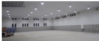
工場施設（栃木、914m 2 、21mスパン、構造材はスギ材・カラマツ合板で国産100%、4mスタッド+基礎高2m）
